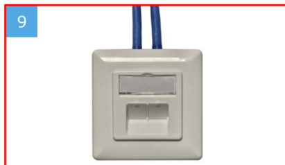
Einrahmen, Datendose und Zentralplatte befestigen. Fasten frame, data outlet and central plate.
